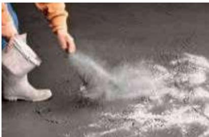
Una vez aplicado, PENETRON PLUS penetra rápidamente en el hormigón. Como parte integral de la superficie de hormigón, PENETRON PLUS elimina los problemas normalmente asociados con los recubrimientos (como la descamación, el polvo, el astillado y la delaminación). Con la humedad de la placa fresca, el crecimiento de cristales se produce rápidamente para garantizar un sellado permanente contra la entrada de agua.
