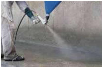
PENETRON solo se mezcla con agua y se puede aplicar en los lados positivo o negativo del concreto con un pincel o un rociador. En presencia de humedad, penetra profundamente en la estructura. La reacción química posterior llena las microgrietas, los poros y los capilares con una red insoluble y permanente de cristales.
