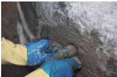
PENEPLUG se cura en unos 30 a 60 segundos después de mezclar e incluso se puede usar bajo el agua. No contiene compuestos orgánicos volátiles y es seguro para su uso en espacios confinados interiores y exteriores.
