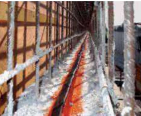
**PENEBAR PRIMMER** se aplica primero en el lugar donde debe estar el tope de agua. Se aplica rápida y fácilmente en la obra con un simple pincel.
